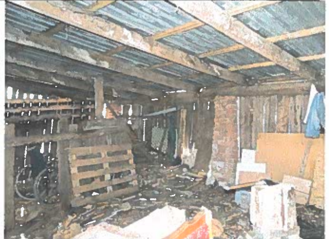
Fot. Nr 17. Stan pomieszczenia w budynku.
