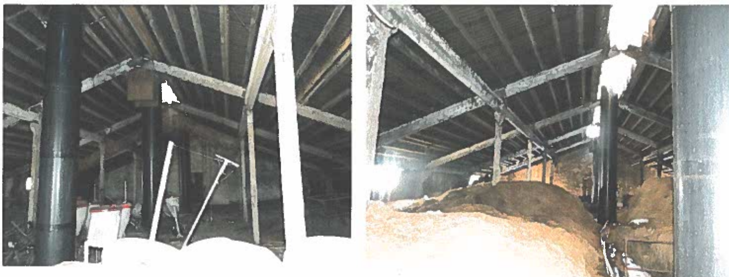
Fot. Nr 12-13. Stan pomieszczeń na piętrze.
