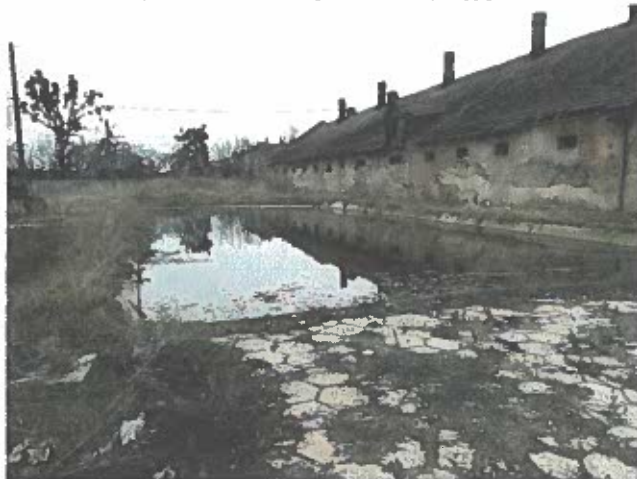
Fot. Nr 36-37. Płyta obornikowa i wlot do zbiornika.
