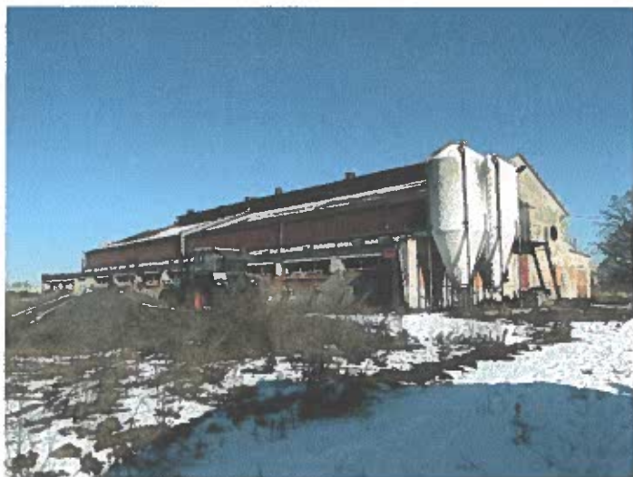
Fot. Nr 6-7. Widok ogólny na budynek.
