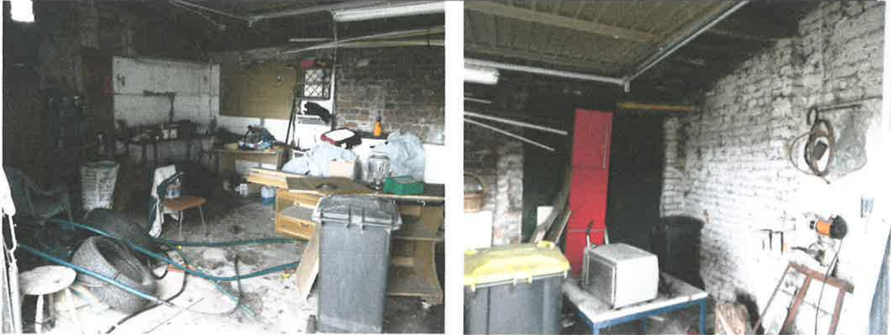
Fot. Nr 12-13. Pomieszczenie w budynku gospodarczym.
