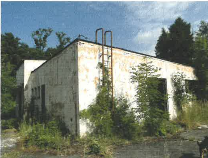
Fot. Nr 2-3. Ogólny widok na budynki.
