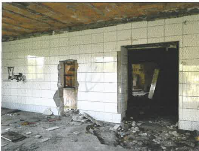
Fot. Nr 8-9. Stan pomieszczeń.
