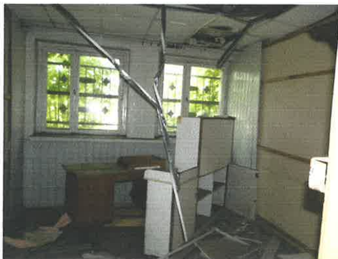
Fot. Nr 12-13. Stan pomieszczeń.
