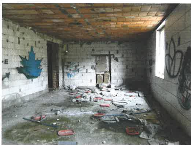
Fot. Nr 10-11. Stan pomieszczeń.
