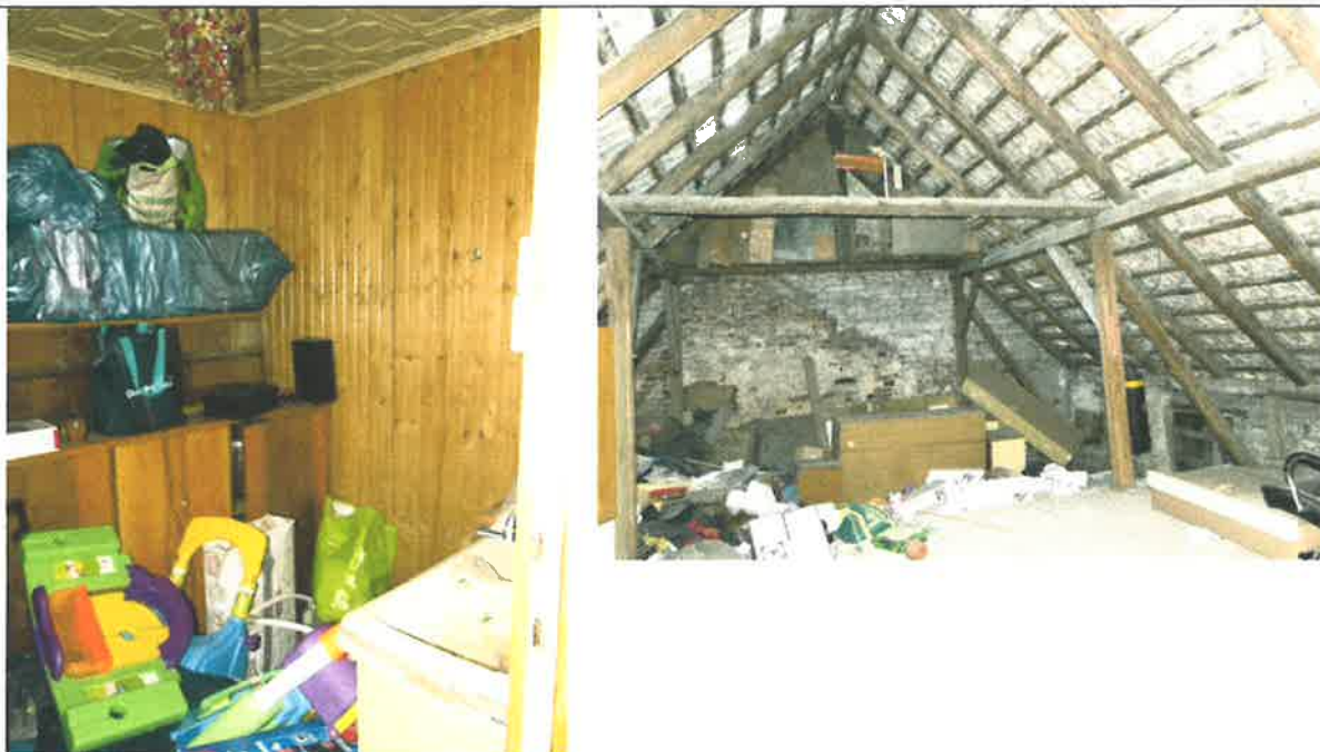
Fot. Nr 16-17. Pomieszczenie gospodarcze i część strychowa.
