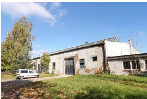
Fot. Nr 2-3. Widok na halę z zewnątrz- dz. nr 449/23.
