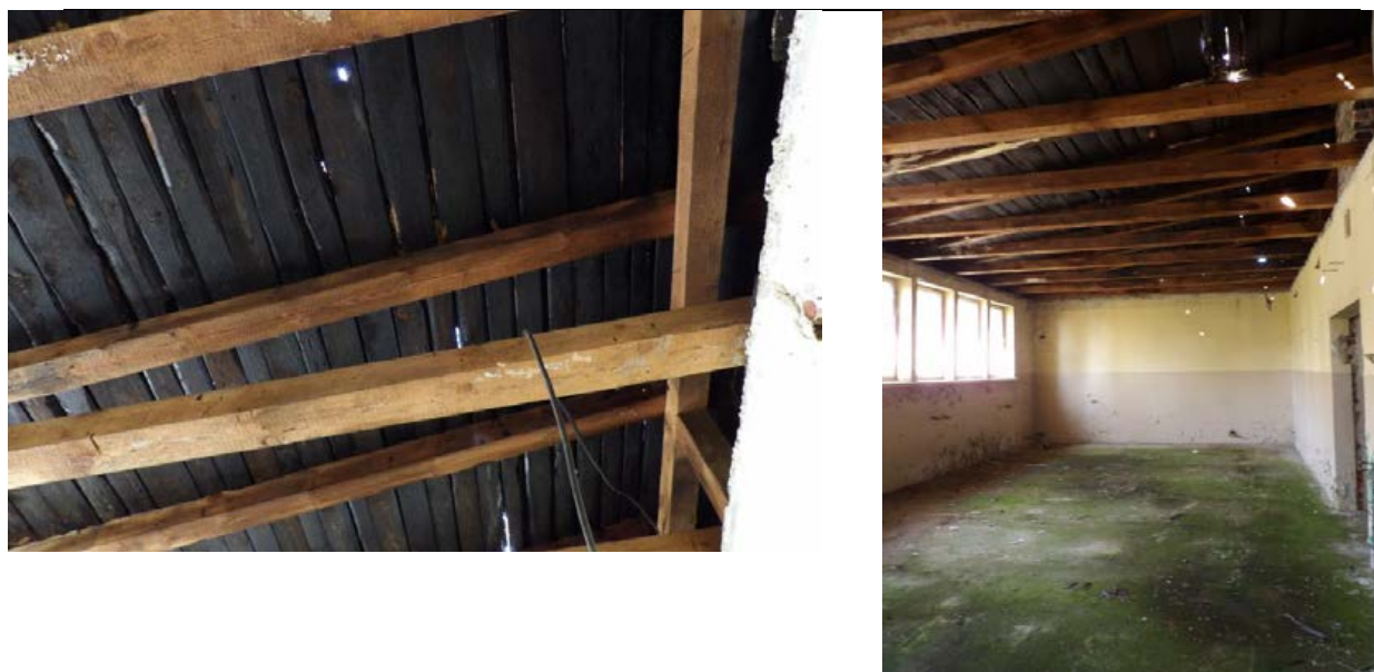
Fot. Nr 16-19. Stan pomieszczeń.
