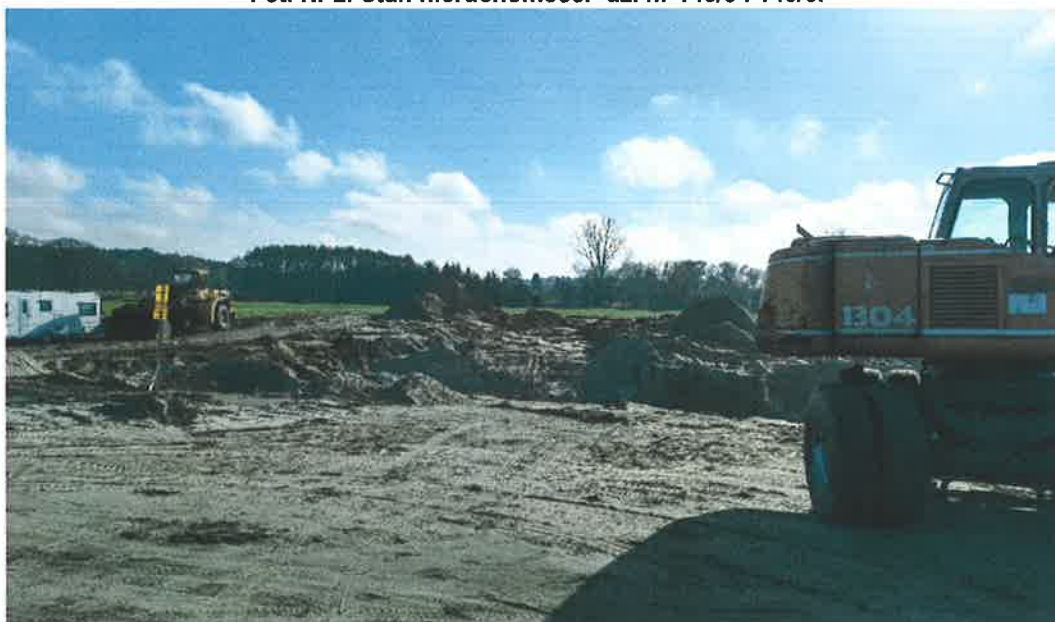
Fot. Nr 3. Stan nieruchomości- prace budowlane na dz. nr 146/6.
