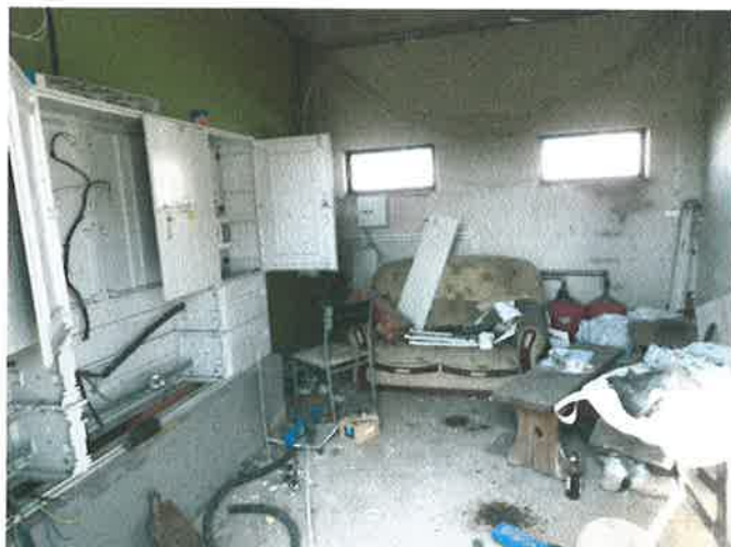
Fot. Nr 6-7. Pomieszczenia w budynkach.
