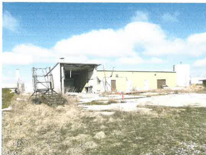
Fot. Nr 4-5. Budynki
