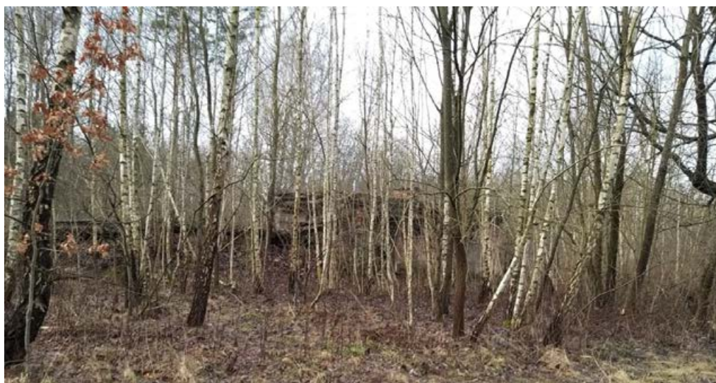
Budynek gospodarczy nr inw. 455 na działce nr 303/117.
