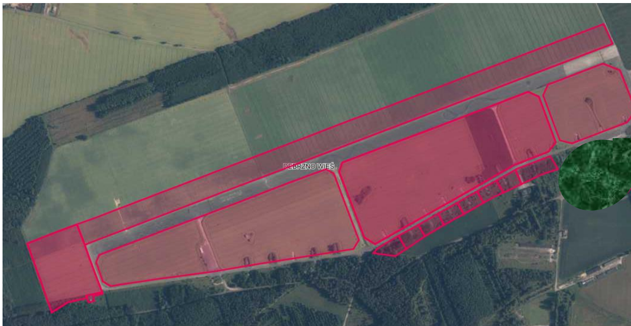
Rysunek nr 12 – Wschodnia część nieruchomości z działkami niezabudowanymi i z działkami na których posadowione były hangary.
